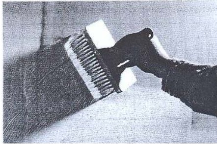
ნახ. 16.37. საბათქაშე გრუნტის დატანა კედლის ზედაპირზე
