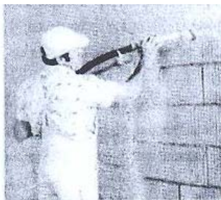
ნახ. 16.41. კედლის ზედაპირზე საბათქაშე დუღაბის დატანა საბათქაშე საცმის საშუალებით
