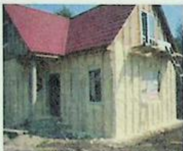
სურ. 5.52. კედლის თბოიზოლაცია ქაფპოლიურეთანით
