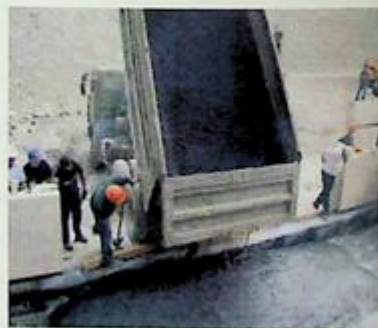
სურ. 5.26. ასფალტობეტონის დაგება
