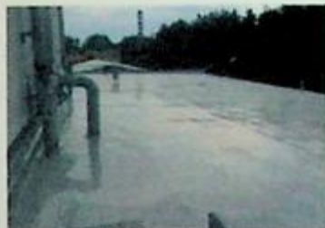
სურ. 5.40. მასტიკის დაფარვის დადება სურ. 5.41. მასტიკის ბურული
