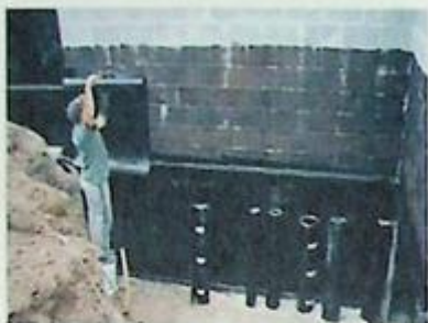
სურ. 5.42. წებოვანი რულონური ჰიდროიზოლაციის მონტაჟი
