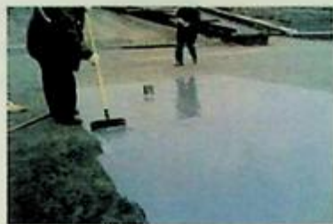
სურ. 5.40. მასტიკის დაფარვის დადება სურ. 5.41. მასტიკის ბურული
