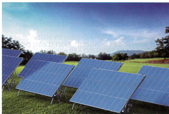
des panneaux solaires
