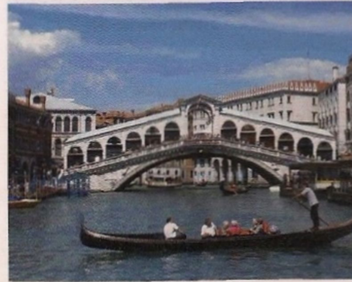
● Ponte di Rialto
