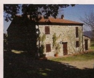
• casa colonica ristrutturata
