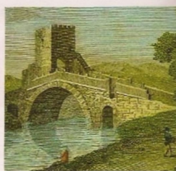
● Immagine di un ponte della via Salaria
