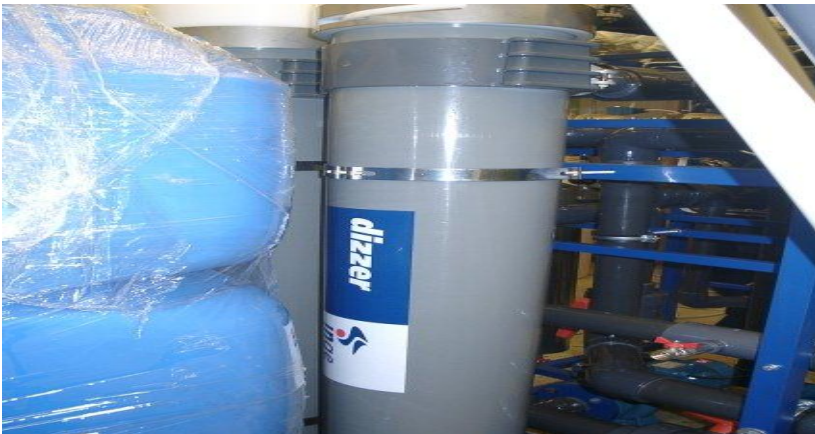
ნახ.10. ულტრაფილტრაციული სისტემა გერმანული მოდულების საფუძველზე კომპანია „ოსმოსი“
