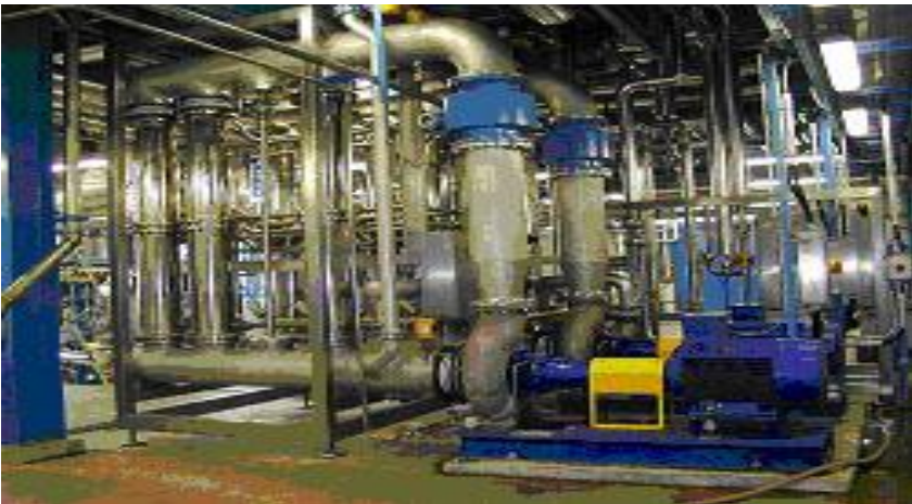
ნახ.42 ულტრაფილტრაციული დანადგარი წვენის და ღვინის გაფილტვრისათვის
