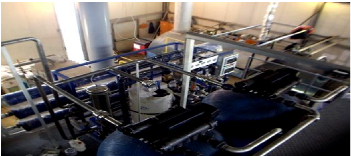
ნახ. 62 წყლის გაწმენდის ულტრაფილტრაციული სისტემები ალკოჰოლიანი სასმელების ქარხანაში (ქ. სანკტ-პეტერბურგი).
