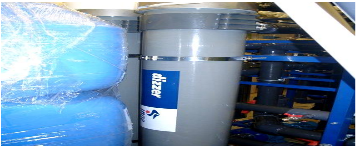
ნახ.61 ულტრაფილტრაციული სისტემა გერმანული მოდულების საფუძველზე. კომპანია „ოსმოსი“
