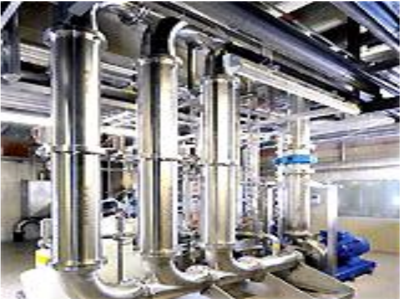
ნახ.35 ულტრაფილტრაციული დანადგარი ღრუ ბოჭკოებით “PALL”
