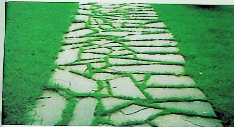
სურ. 68. ფილებისაგან გაკეთებული საბალო გზის საერთო ხედი, რომელთა შორის დარჩენილი მანძილი შევსებულია ბალახით
