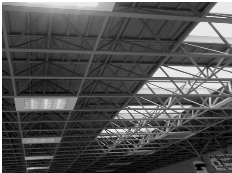
სურ.10. ერთსართულიანი შენობა ლითონის მზიდი ელემენტებით. გადახურვა სტრუქტურული კონსტრუქციით (ამსტერდამი)
