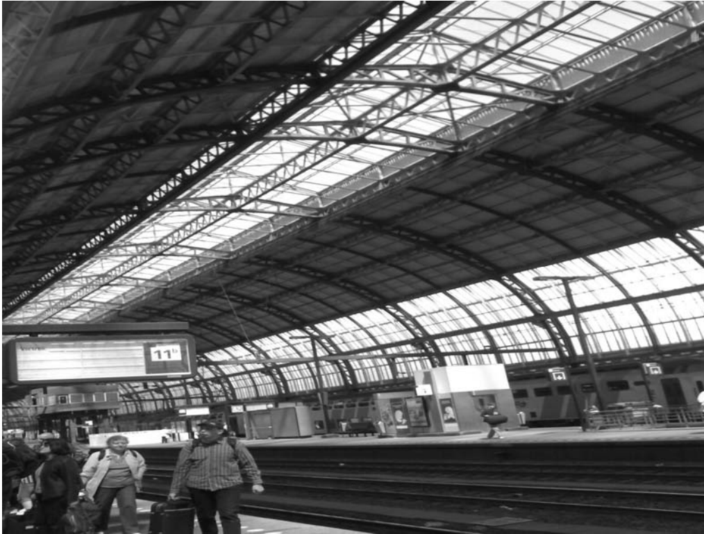
სურ. 5 ამსტერდამი. რკინიგზის სადგური. გადახურვა ლითონის მზიდი ელემენტებით
