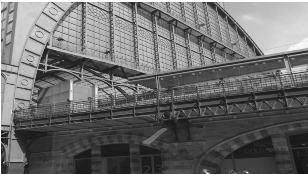
სურ. 2 ანტვერპენი. რკინიგზის სადგური. ფასადი – შევსება ლითონის მზიდი ელემენტებითა და მინით
