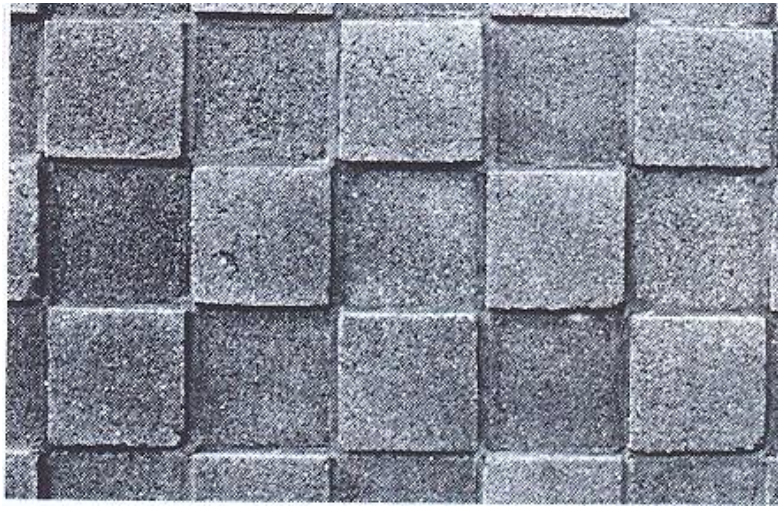
ნახ. 188. საპირე რელიეფური დეკორატიული წყობა ქვების შვერილებით.
