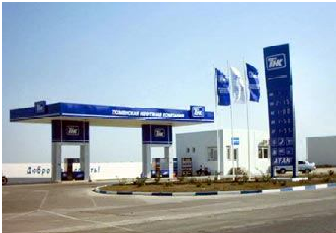
Рис. 12.19. Общий вид заправочной станции
