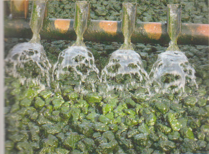
Bild 4.3: Drehstrenger am Tropfkörper
