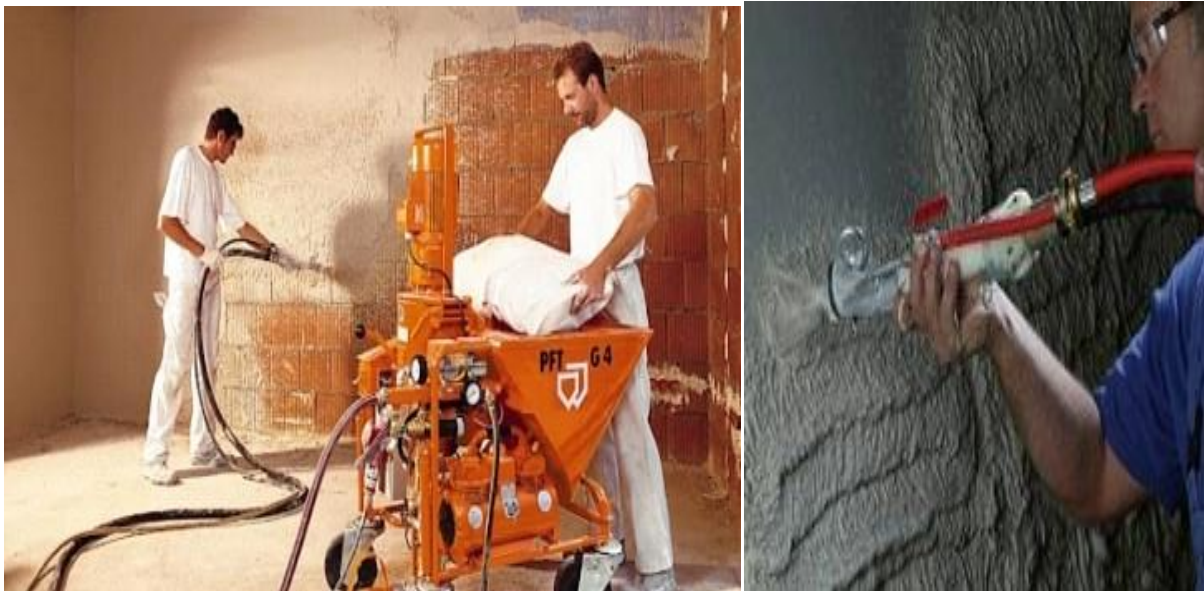
ნახ. 78 დუღაბის მექანიზირებული წასმა მფრქვევანებით.
