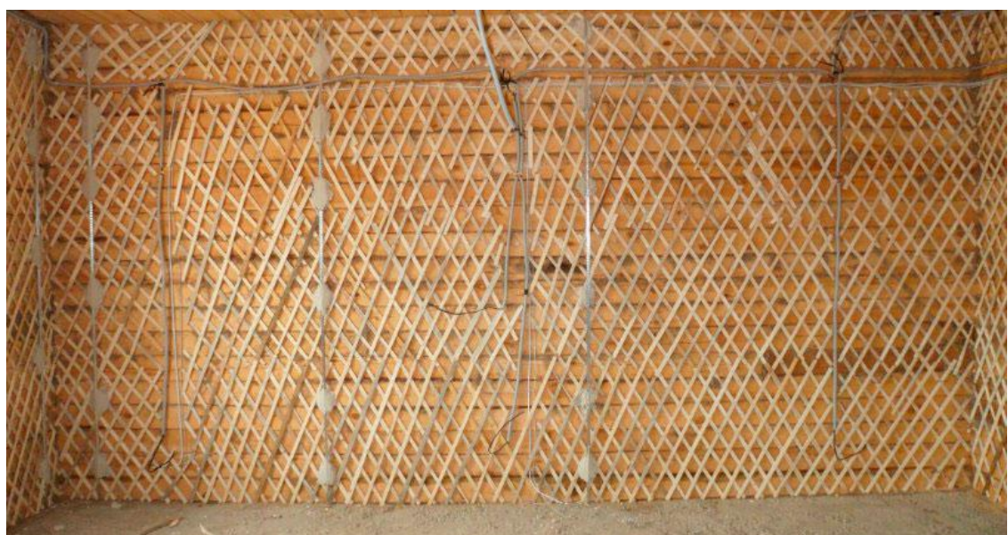
ნახ.58 ხის ზედაპირზე გაკრული ტკერები და დატანილი შუქურა-ნიშნულები.
