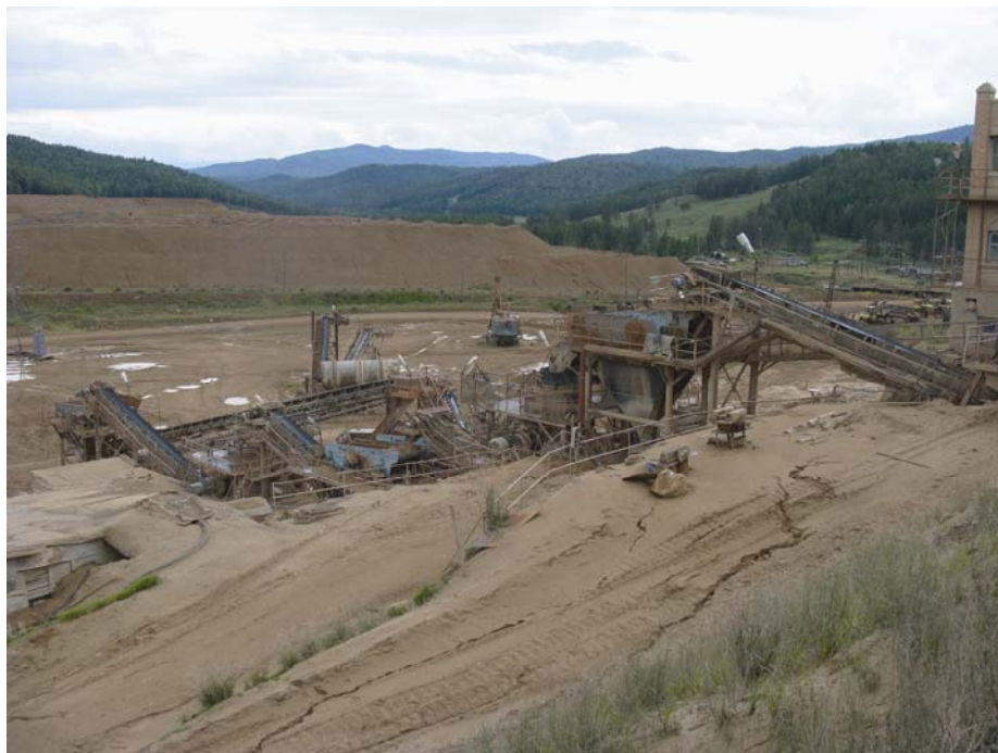
Рис. 42. Горный лесной ландшафт, нарушенный антропогенной деятельностью. Кучное выщелачивание золота на месторождении Чазы-Гол, Республика Хакасия
