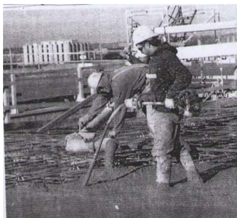
ნახ. 11.2.4. ბეტონის მიწოდება და შემკვრივება ხელის ვიბრატორებით.
