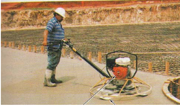
ნახ. 11.2.10. ზედაპირის მოსაპირკეთებელი ხელის მანქანა
