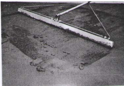
ნახ.11.2.6. ახლადჩაწობილი ბეტონის მოსწორება ხელით
