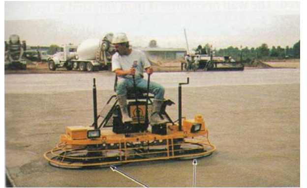
ნახ. 11.2.11. ზედაპირის მოსაპირკეთებელი მანქანა
